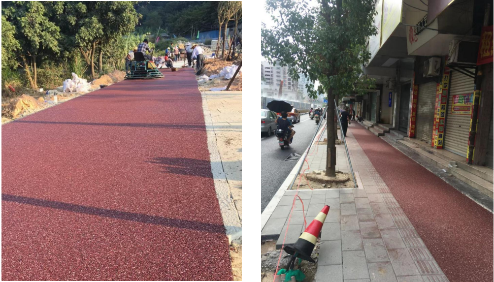
图 1 聚合物透水混凝土路面施工现场
