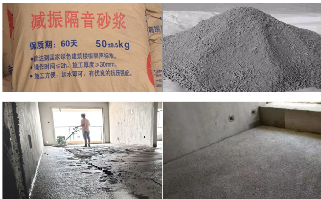
图 1 隔声砂浆施工现场
