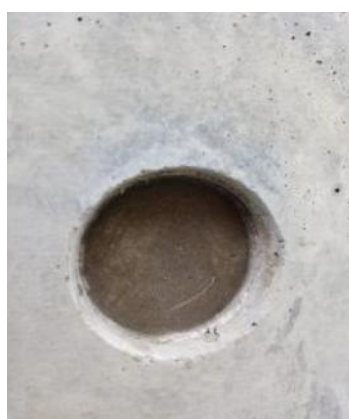
图 6.6 封堵成型后的螺旋孔
