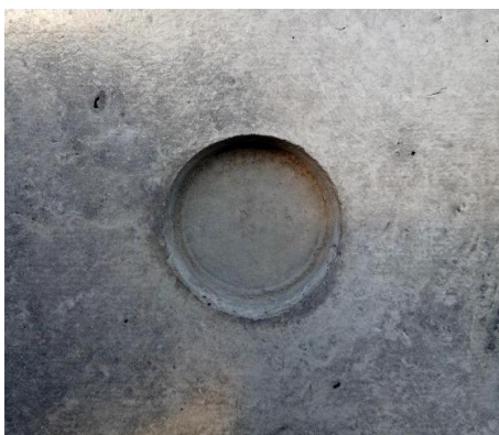
图 6.7 封堵后完美成型的螺旋孔
