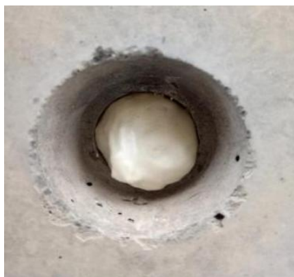
图 6.3：密封发泡剂封堵
