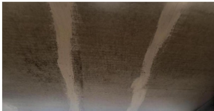
图 27 板底裂缝处涂抹石灰水
