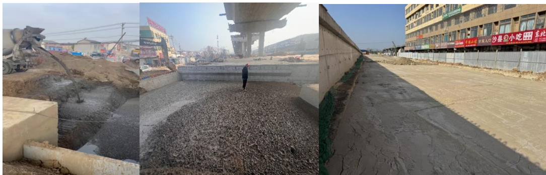
图 3-4 交通工程桥台、涵背、路基等流态固化土回填
