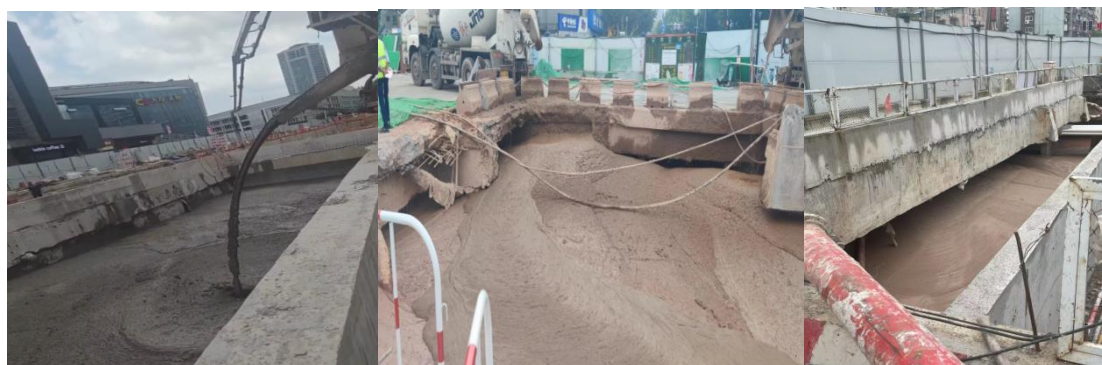
图 3-2 城市轨道交通工程地下车站顶板回填应用
