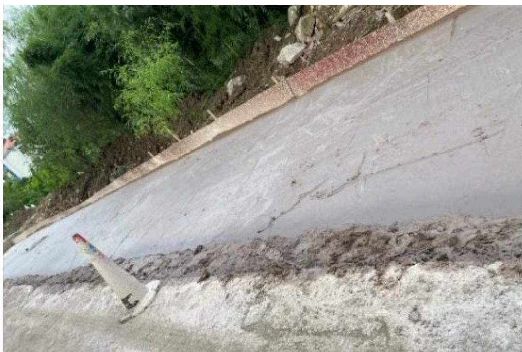
图 3-5 柯诸高速工程中流态固化土填筑道路拼宽路基
