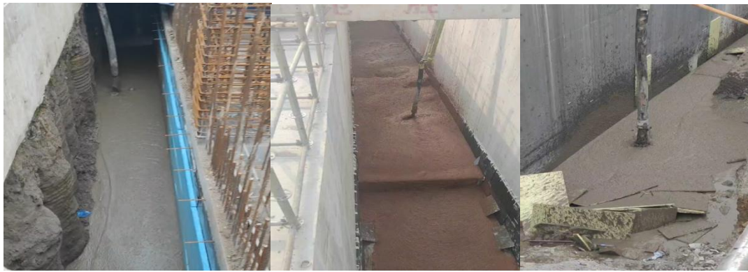
图 3-1 建筑构筑物基槽（肥槽）回填
