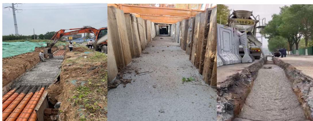
图 3-3 电力、供水、污水和煤气等管道回填，广泛用于城市更新改造项目
